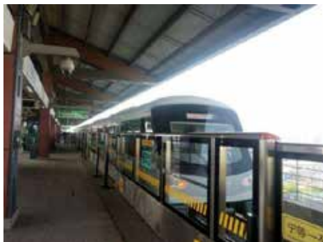
站台安全防护门防冻
