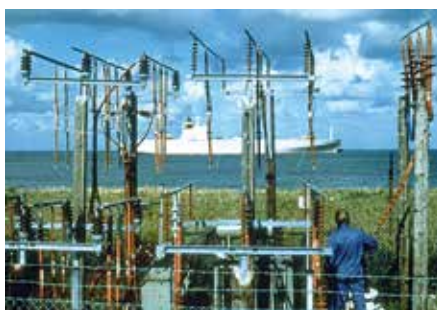
Raychem Cuxhaven，德国长期实验基地。瑞侃终端在北海海边试验测试已经 40 年。
