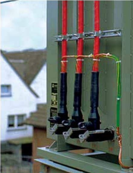
肘型端头用于户外SF 6 变压器
